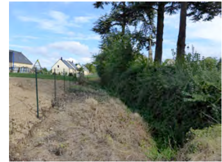
😞 Absence d'espace suffisant pour l'entretien
