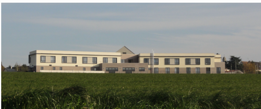
Vue sur la nouvelle maison de retraite depuis l'ouest
