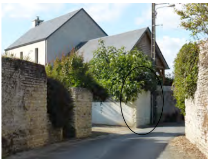
😊 Mur construit dans la continuité d'un mur existant. avec la même hauteur
