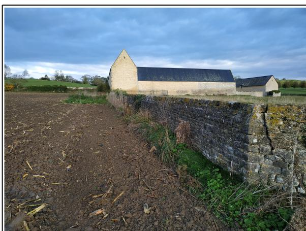
Les eaux de toitures des bâtiments sont rejetées directement sur le terrain sans rétention ou infiltration. On retrouve également une dalle bétonnée accolée à un ancien bâtiment agricole et au mur sur la parcelle C n°11 ce qui provoque des accumulations d'eaux pluviales des gouttières à cet endroit.
