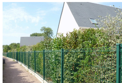
😞 Clôture implantée côté extérieur du lot privé
