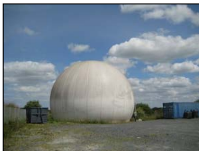
Réservoir de stockage de biogaz (Source : Pays du Bessin Au Virois)
